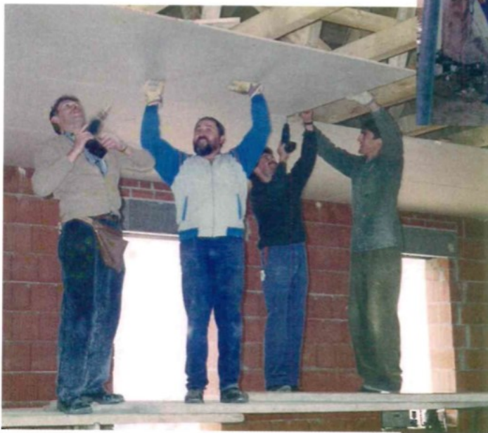
Deckenmontage im Saal
